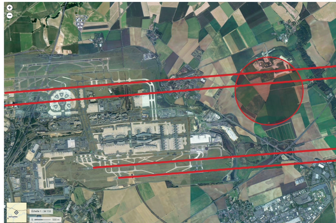
Aéroport de Roissy. Dans l'axe des pistes de Roissy : le site de Villeneuve-sous-Dammartin.
