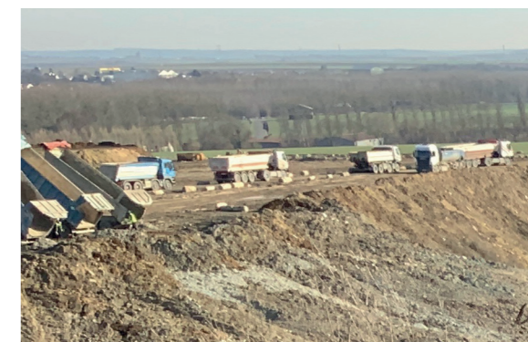
Site d'ECT de gestion et de réutilisation des terres excavées à Villeneuve-sous-Dammartin.
