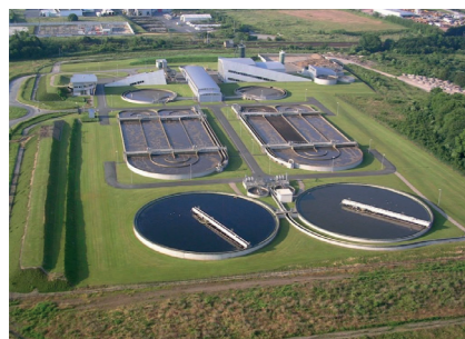
Station d'épuration © Arras communauté urbaine.
