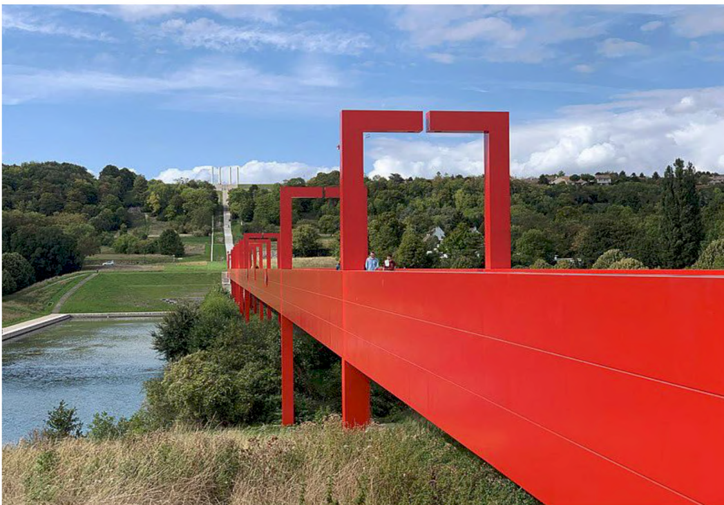
Passerelle de l'Axe Majeur de Dani Karavan à Cergy Photo Chabe, 2020
